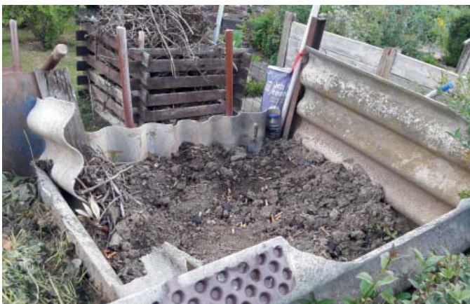
Gefährlich! Asbestplatten zweckentfremdet als Komposteinfassung. Erde und Arbeitsgeräte lösen beim Kontakt mit dem Asbest gesundheitsschädliche Fasern ab. Dieses Asbest muss sofort fachgerecht entsorgt werden!
