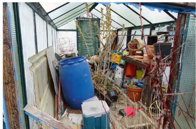
Wird ein Gewächshaus nicht mehr zum Anbau von Pflanzen verwendet, sondern wird es wie hier als Abstellkammer genutzt, ist es abzureißen.
