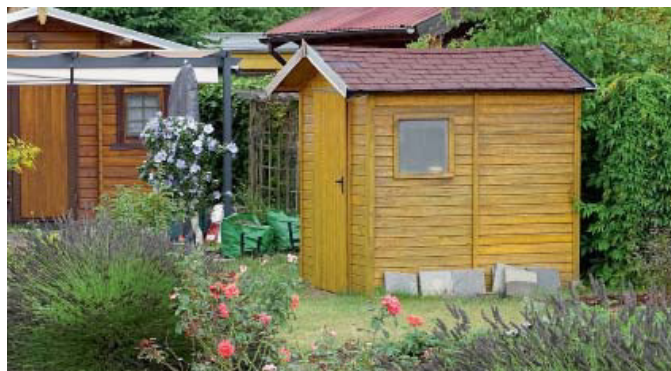
Separate Schuppen sind unzulässig. Ist die Laube kleiner als 24 m 2 , kann ggf. an die Laube ein Schuppen angebaut werden (Bauantrag).
