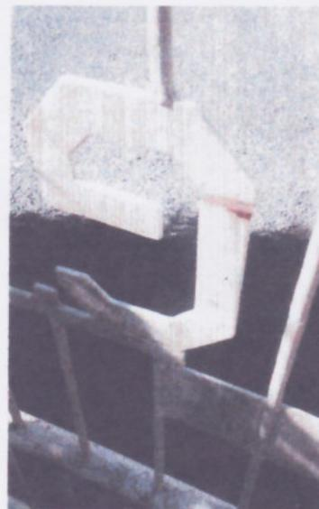
Durchrostung an einigen Stellen, die verschweißt werden mussten, bevor die neue Beschichtung aufgebracht werden konnte.
